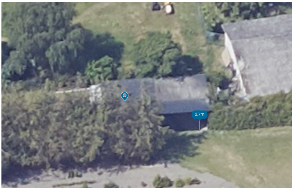
Figur 3: Skråfoto af garagen mod sydvest set fra østlig retning. Garagen har en byggehøjde på ca. 2,7 meter.
